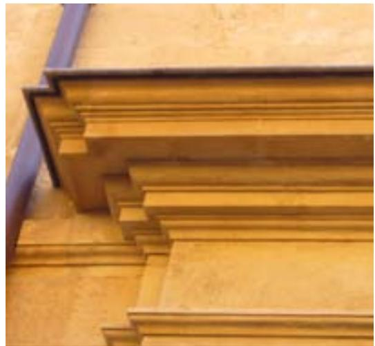
*Ci-dessus exemples de couvertines plomb et zinc sur partie saillante, cliché VW.*
